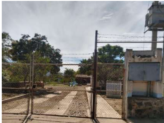
Fuente: Dirección de Agua Potable, Drenaje y Alcantarillado Instalación del pozo 6, Colonia Ejidal
