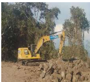
Fuente: Oficialía Mayor Excavadora
