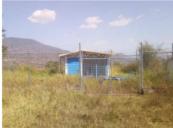
Fuente: Dirección de Agua Potable, Drenaje y Alcantarillado Instalaciones del pozo de agua, agencia El Cortijo
