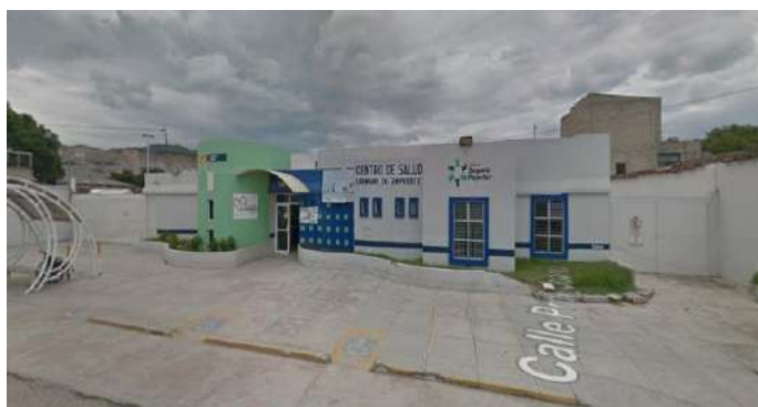
Fuente: Dirección de Salud, Instalaciones del Centro de Salud Urbano de Zapotiltic, Jalisco 2022
