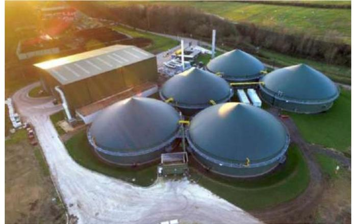
La planta es de Digestión Anaerobia de vía seca permite transformar la materia orgánica en Biogás y con este generar energía eléctrica, además que los residuos se transforman en un digestato pasteurizado como biofertilizante líquido
